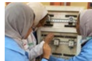
P. 86 - Techniciennes au travail ©IECDEGYPT
