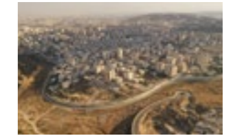
P. 114 - Israël et la Palestine divisés par le mur de sécurité, vue aérienne
